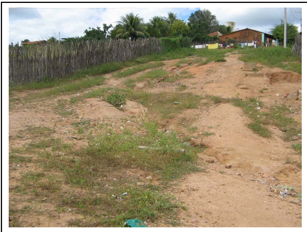
Foto 06 - Caminhamento da adutora de FoFo até a caixa de passagem, vendo-se ao fundo a favela onde se localiza a caixa de passagem.
