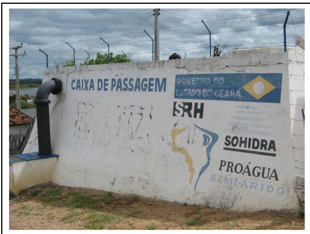
Foto 07 - Caixa de passagem, vendo-se a tubulação de extravasão e de saída (caixa onde se inicia a adutora).
