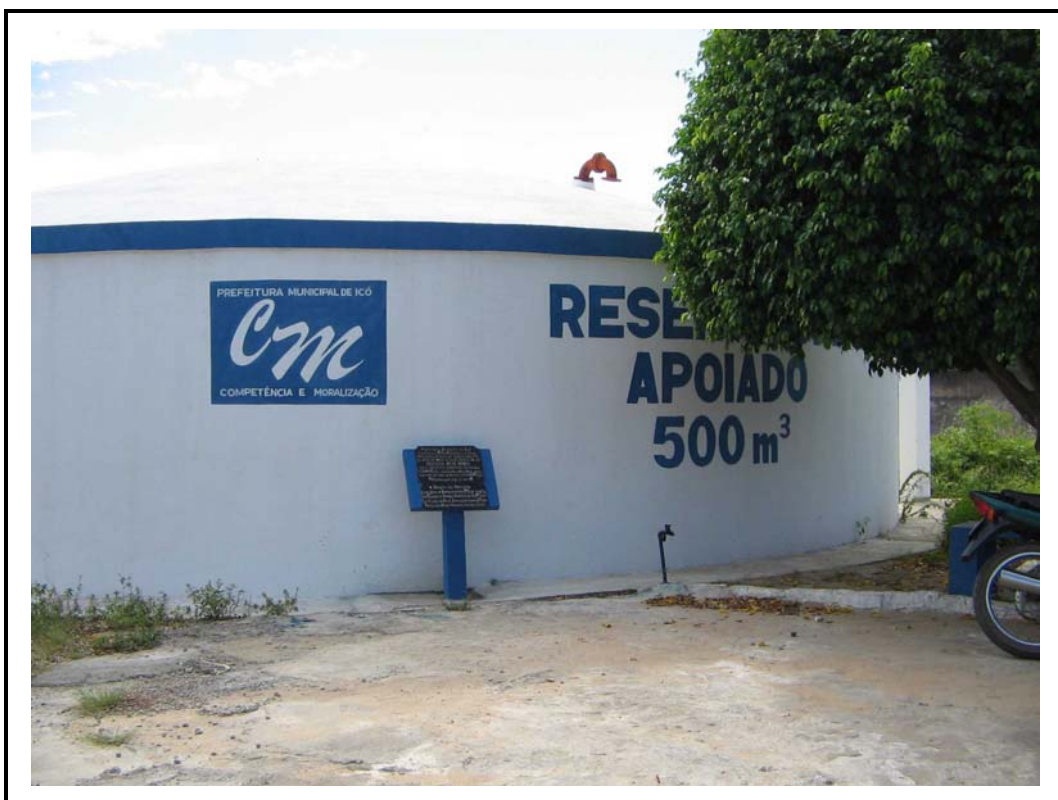
Foto 19 - Reservatório apoiado de água tratada.
