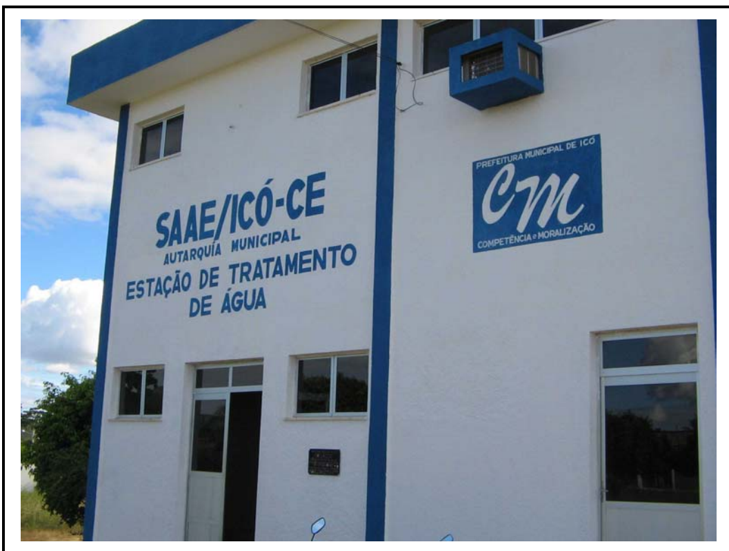
Foto 12 - ETA - vista geral.
